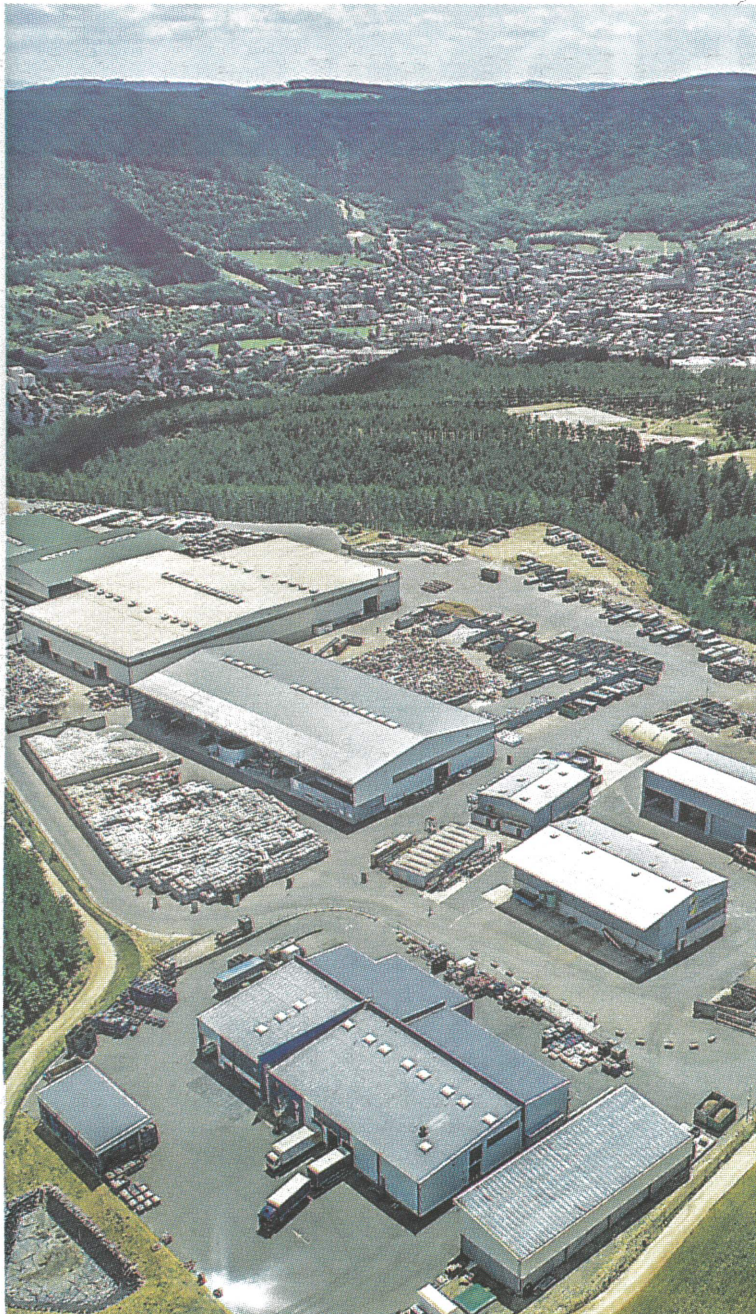
Installée à Mende, l'entreprise est en train d'agrandir ses locaux.
